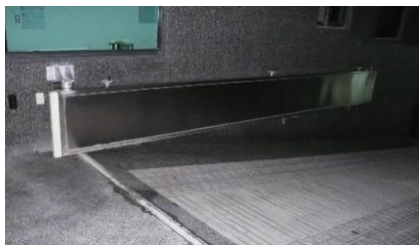
圖 5-2-10 車道口裝設金屬防洪（開啟式）閘門
