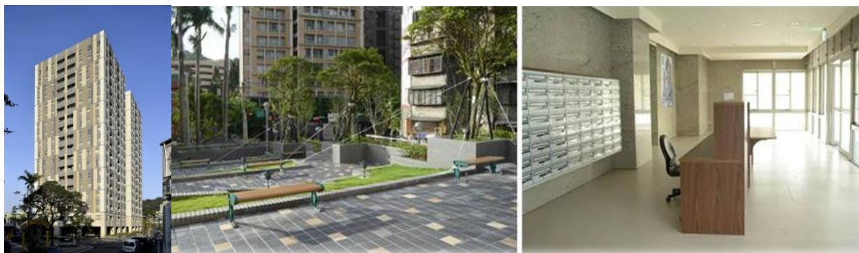
圖 2-11 興隆一區公共住宅外觀及室內外公共設施
