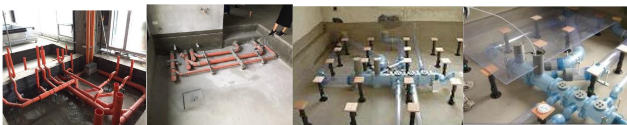
圖 5-5-1 建築同層排水系統之降板結構與設備器具
