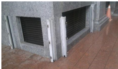
圖 5-2-10 車道口裝設金屬防洪（開啟式）閘門 圖 5-2-11 地面層建築主體周圍牆壁，車道防洪閘門高度以下的開口，均需設置防洪閘版
