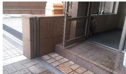
圖 5-2-10 車道口裝設金屬防洪（開啟式）閘門 圖 5-2-11 地面層建築主體周圍牆壁，車道防洪閘門高度以下的開口，均需設置防洪閘版
