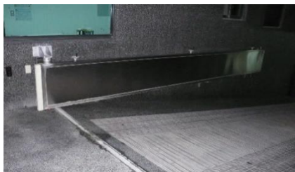
圖 5-2-10 車道口裝設金屬防洪（開啟式）閘門 圖 5-2-11 地面層建築主體周圍牆壁，車道防洪閘門高度以下的開口，均需設置防洪閘版
