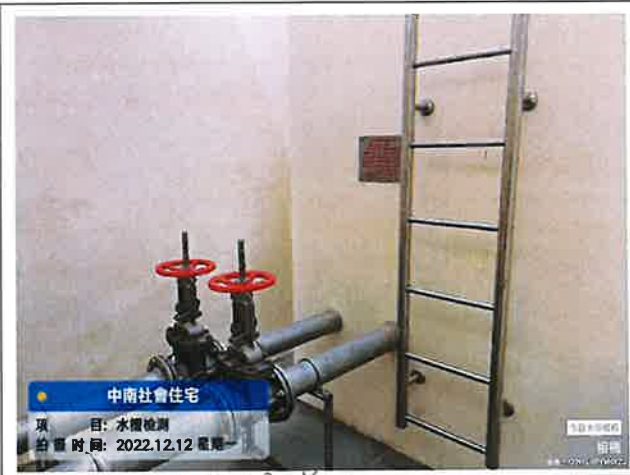
排水、地下、高架水槽 (李保義)
